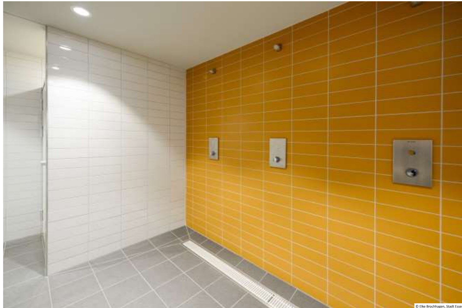
Sanierung der Turnhalle am Erich-Brost Berufskolleg
